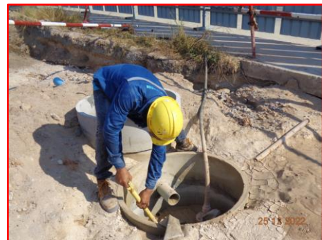
ภาพที่ 2.2-36 การขุดลอกรางระบายน้ำ
